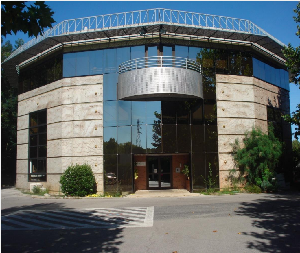
Figure 3. Entrée du bâtiment PS2 (où j'ai réalisé les acquisitions des images)
